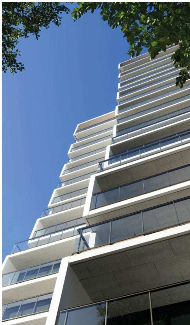
I Brommas landemerke, Alviks Torn, har balkongene fått montert Semullit. Dette minsker støyen inne helt opp til 18.etg.
