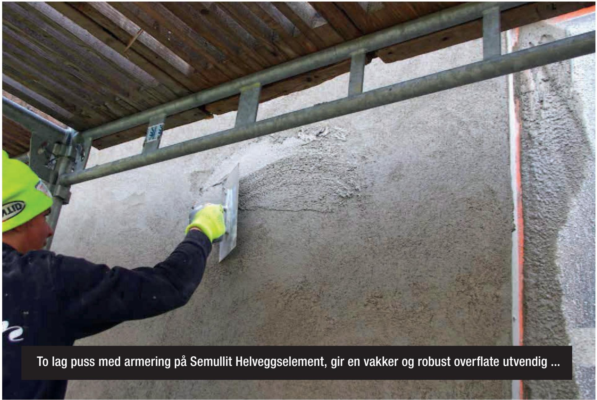
To lag puss med armering på Semullit Helveggselement, gir en vakker og robust overflate utvendig ...
