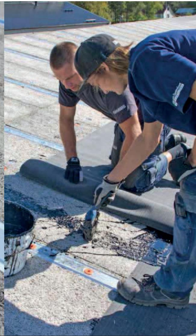
Dampsperre, kompletterende varmeisolering i tak, innfestning av Semullit Sandwich og tettesjikt.
